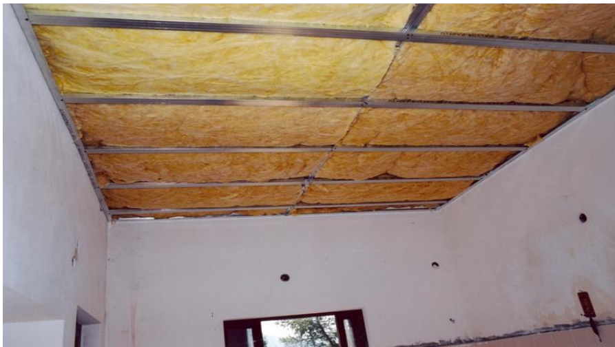
Εικόνα 37 Θερμομόνωση κάτω από την πλάκα.
